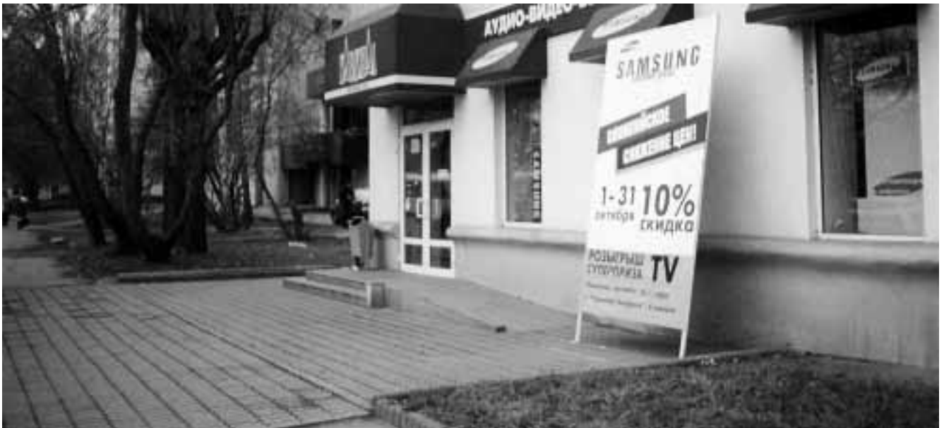
8. Информационный щит перекрывает доступ к пандусу
