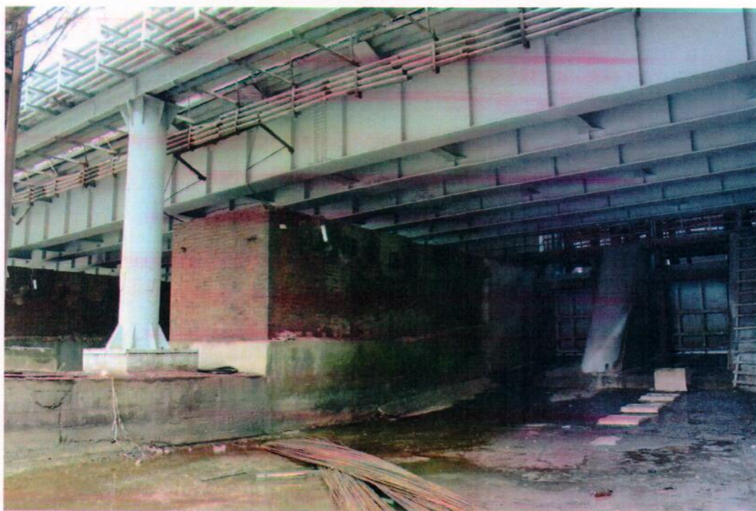
Фрагмент левого быка и нового автодорожного моста.
