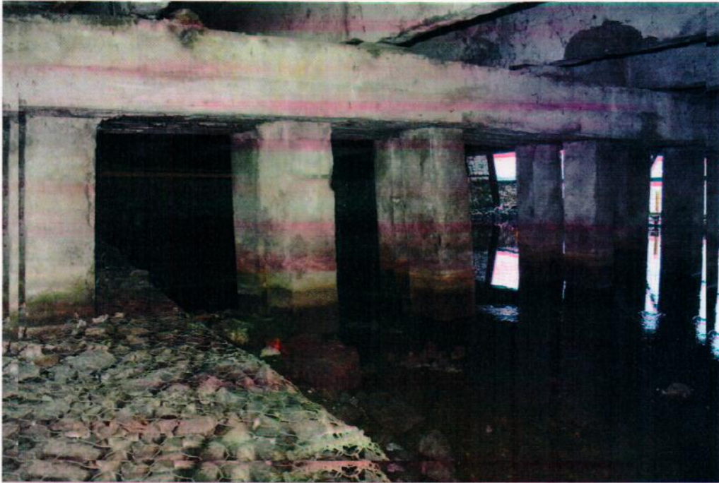
Несущие опоры новой пешеходной эстакады с северной стороны.
