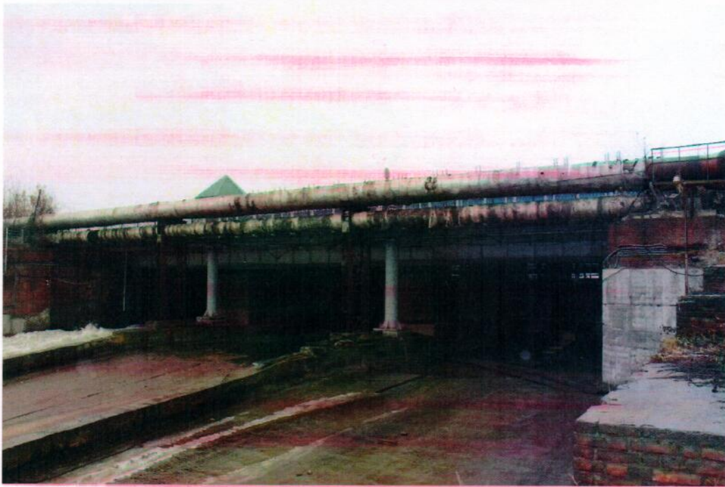
Вид на водосброс с южной стороны.
